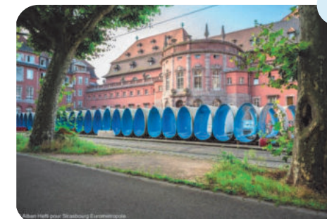
Chantier de réfection du réseau d'assainissement sur le boulevard de la Victoire
