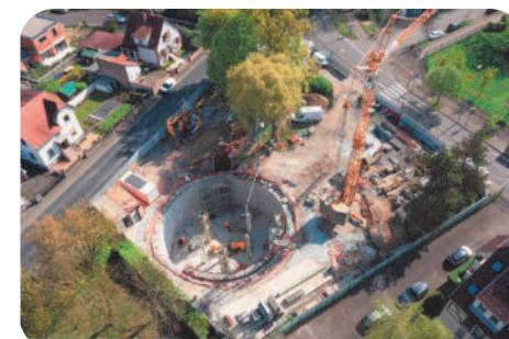
Chantier du bassin d'orage de Lingolsheim
