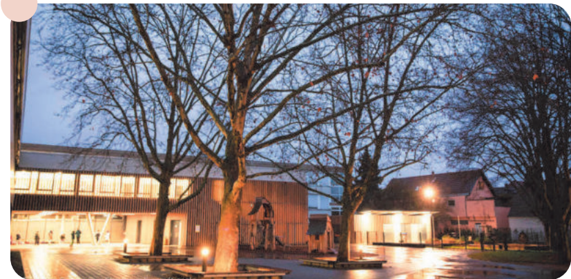
Nouveau bâtiment pour l'École Maternelle Pourtalès : Coût total de l'opération : 1,15 M€ TTC
