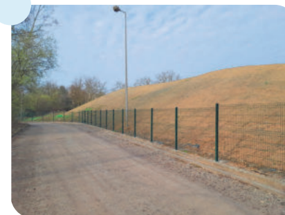
Pollution sur le site des Tanneries à Oswald
