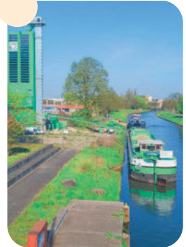
Centrale à béton à Archipel 2
