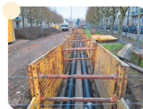
Travaux d'extension des réseaux de chaleur.
