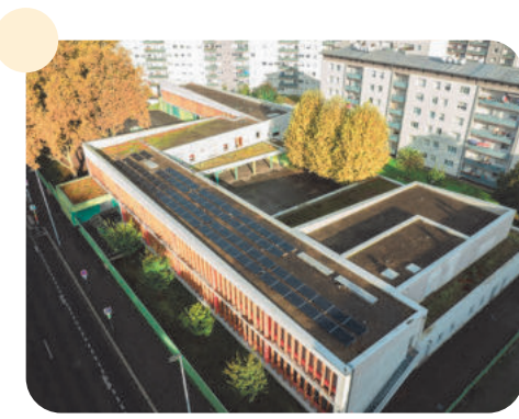
Centrale citoyenne photovoltaïque au groupe scolaire Louvois.
